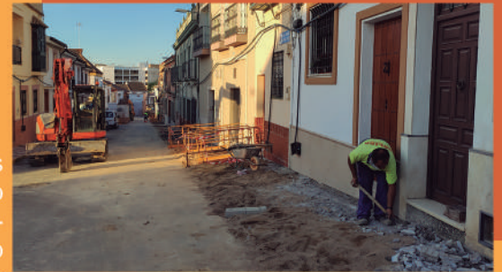
Obras de Aljarafesa en seis calles.
