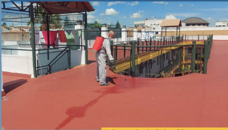
Labores de desinfección en azoteas.
