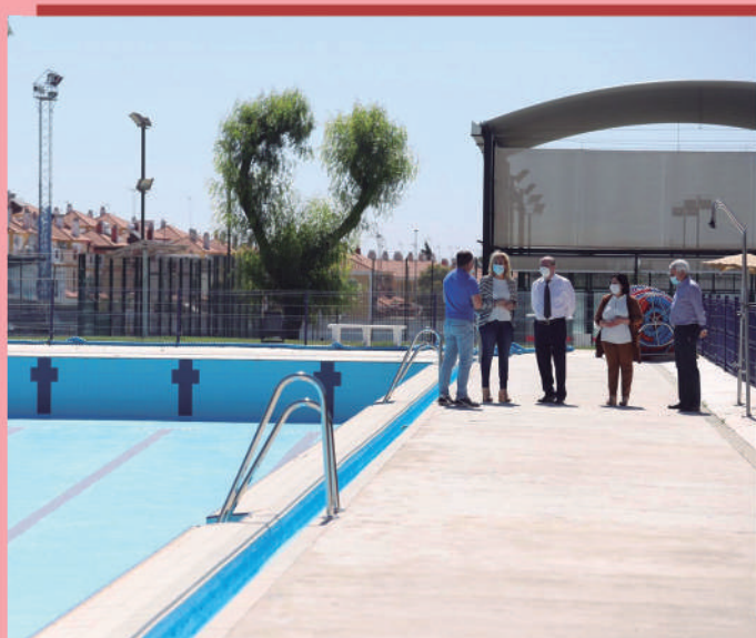
Instalaciones de la piscina de verano.
