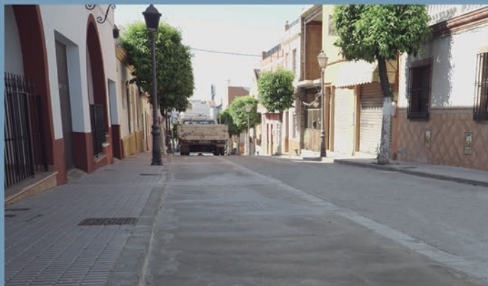
Mejora de las Plazas de aparcamiento en la calle Justo Monteseirín.
